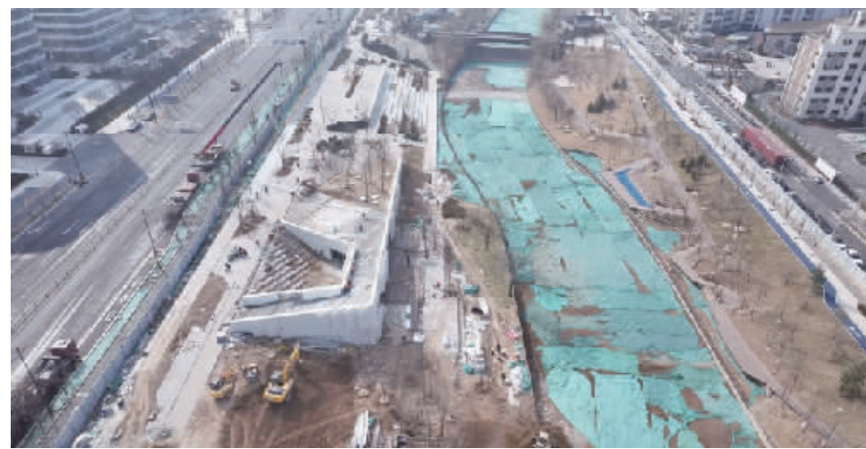
春晖路及杨家河一体化提升工程有望6月底全面建成并开放。(济南日报·爱济南记者 刚永超 摄)
